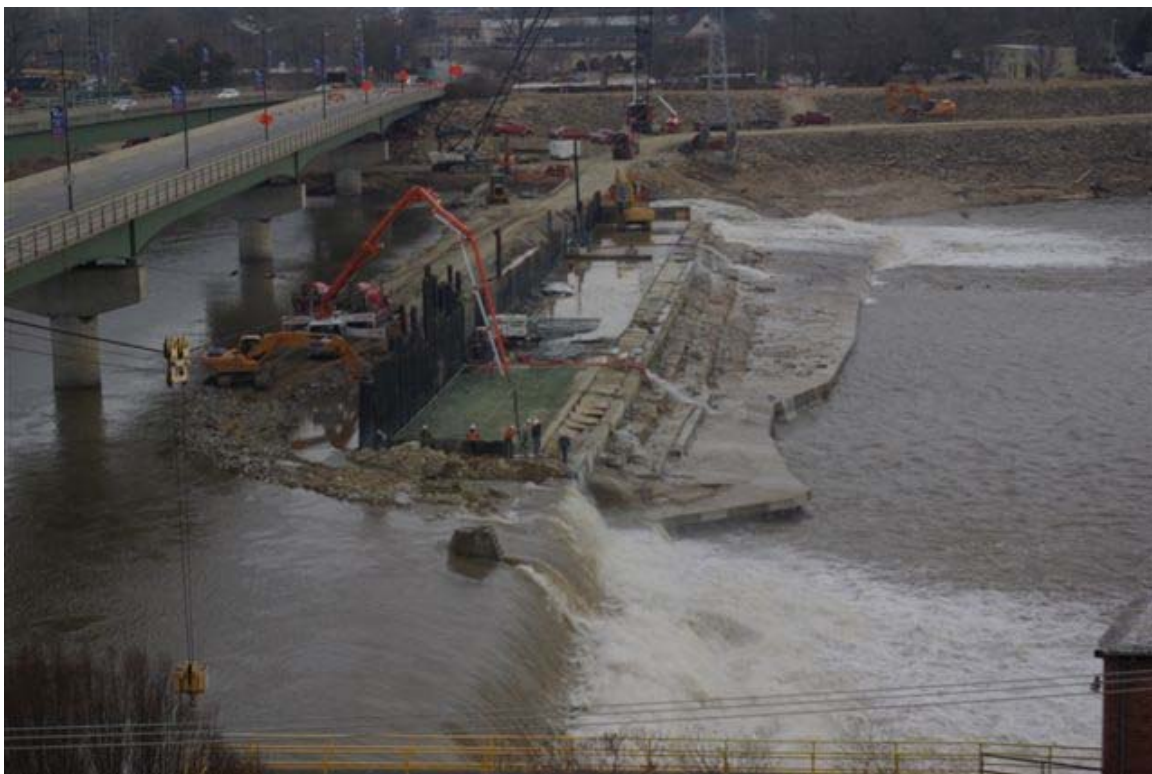
Final concrete cap pour
