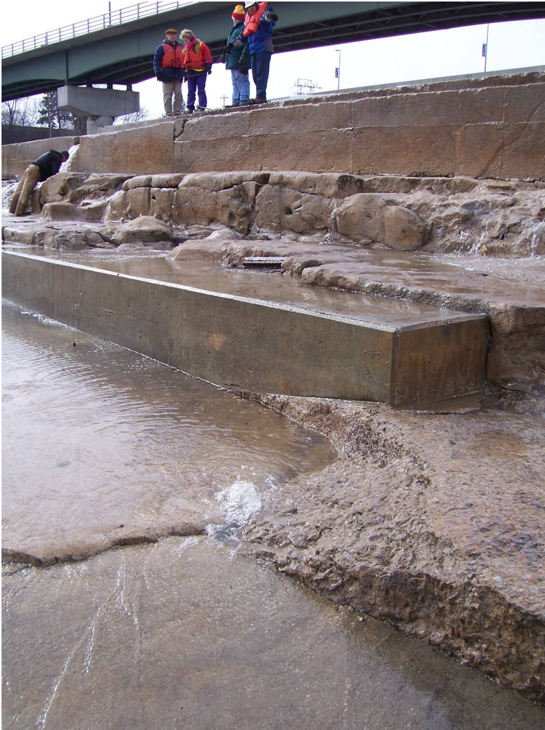
13. Sta 4+40. Leak bubbling up thru start of apron.
