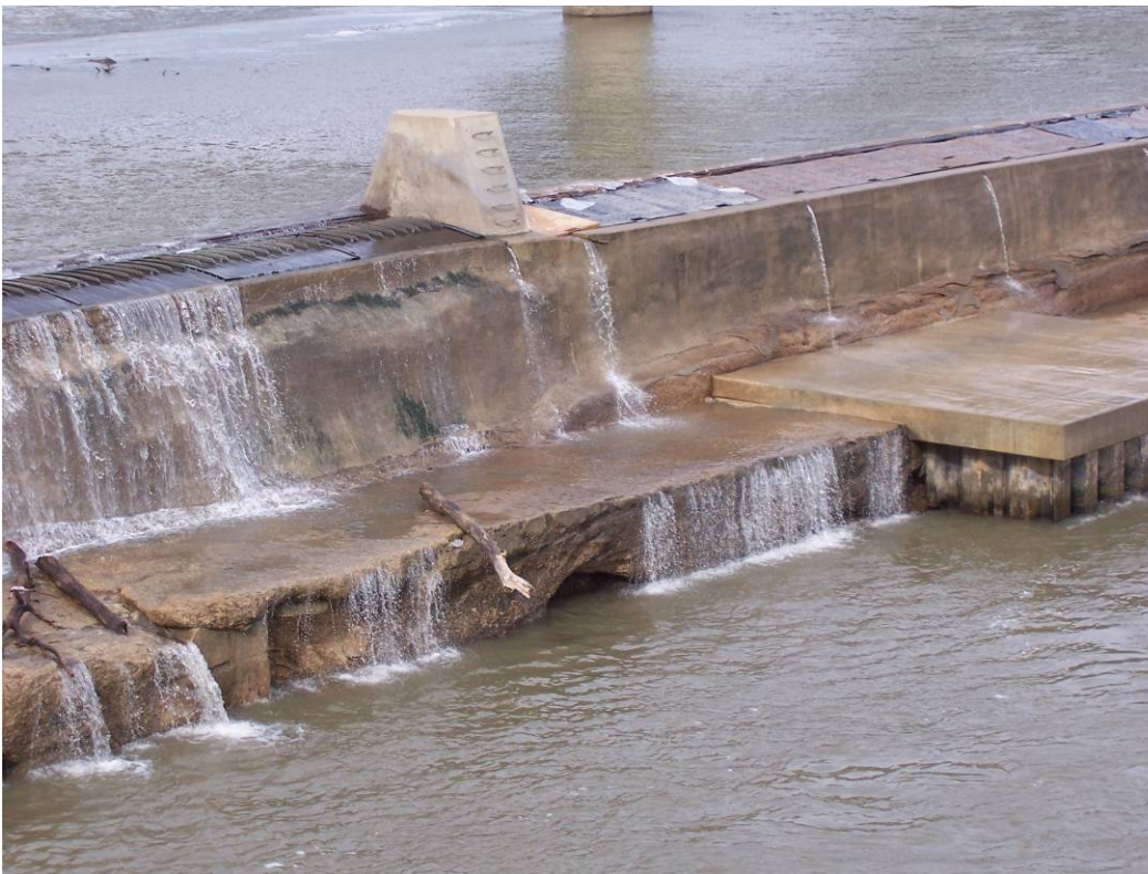
10. Sta 6+35 to Sta 6+75. Scour or eroded concrete under ledge @ Sta 6+60±.
