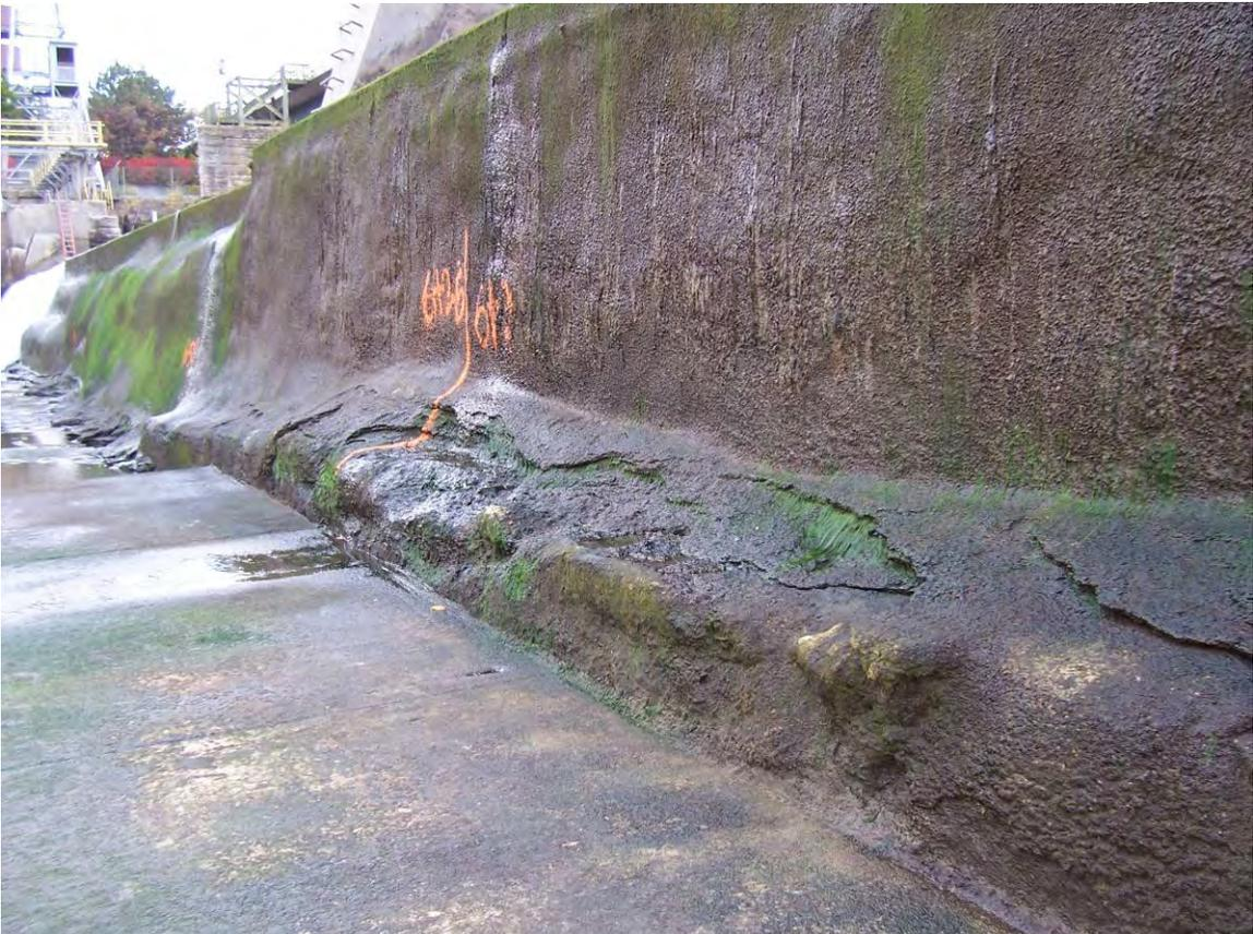
78. Sta 6+25. Eroded shotcrete.
